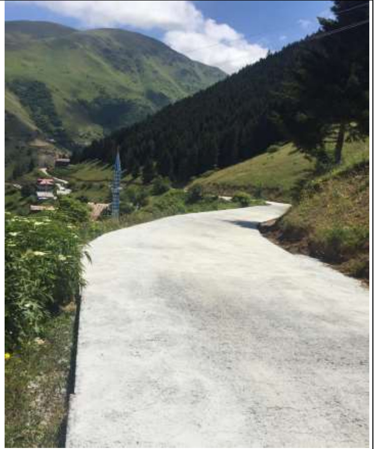
Bahçecik mahallesi beton yol yapım işi 1.209.450,00 TL bedelle ihale edilerek gerçekleştirildi. İhale kapsamında 568 m 3 beton kullanıldı 573 m beton yol yapıldı.
