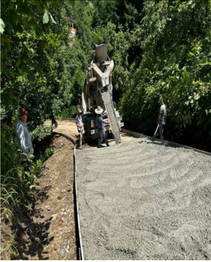
Pervane mahallesi beton yol yapım işi 1.387.000,00 TL bedelle ihale edilerek gerçekleştirildi. İhale kapsamında 657 m 3 beton kullanıldı 745m beton yol yapıldı.
