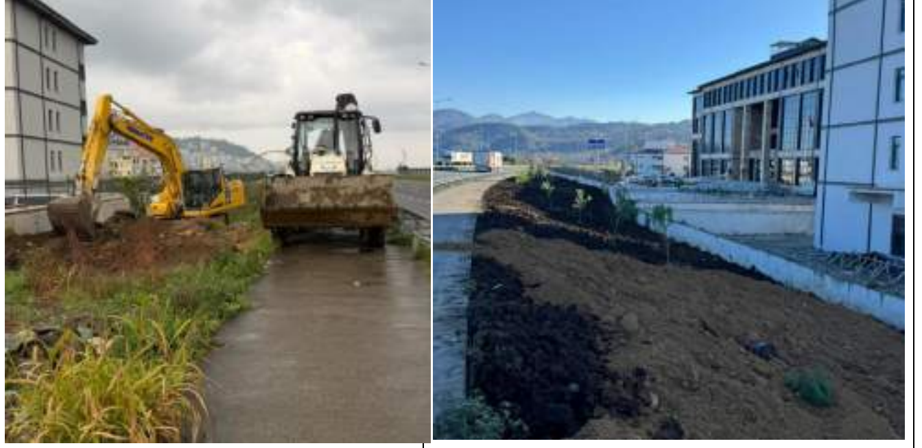
Yeni Adliye binası dış bahçesi peyzaj alanları ve yürüyüş yolları betonlama çalışmalarını 2025 yılı içerisinde çalışmalar yapıldı.
