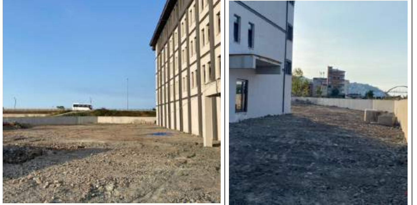
İlçemiz Yolgören mahallesinde yapılmakta olan Cevat Özyurt İlk öğretim okulu saha düzenlemesi.
